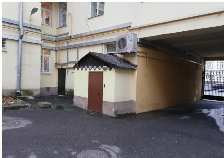
ул. Садовая-Кудринская, д. 14-16 (пристройка)
